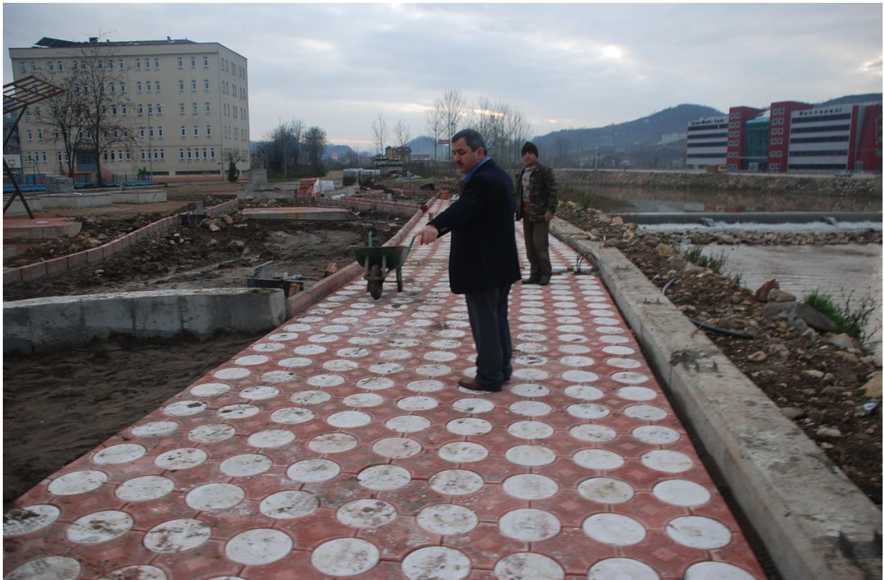
Parke, Bordür, Yol çalışmaları
